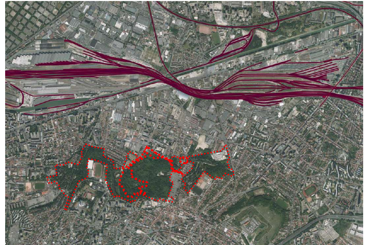
Figure 72: Nœud ferroviaire de Noisy-le-Sec
