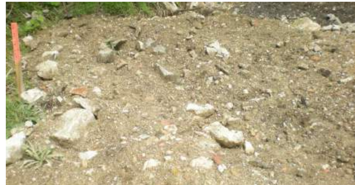
Exemple de l'aspect des remblais
