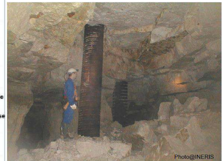
Figure 119: Exemple de profil de pieu au niveau de l'appui N°3 et photographie de pieux traversant – source :EGIS
