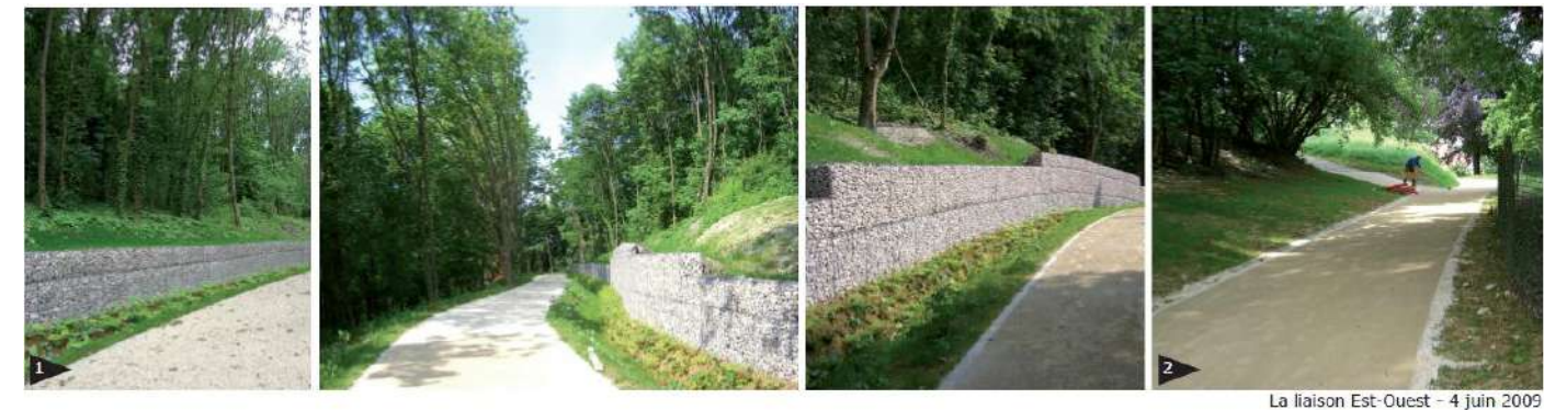
Figure 109: Photographies de la liaison est-ouest en juin 2009 – Source : ÎLEX
